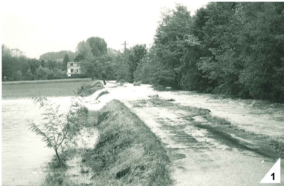
St Jean de Soudain : débordements de la Bourbre par dessus la digue rive droite, sans rupture, en amont de la RD 1.
