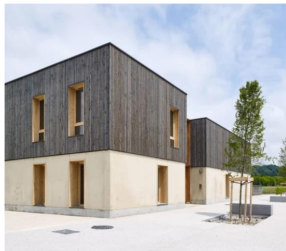
Pépinière d'entreprises "Le Cap" : Construction en béton d'argile coulé et bois ZAC de la Corderie - St-Clair-de-la-Tour Architecte : Reach&Scharff / ©Kévin Dolmaire
