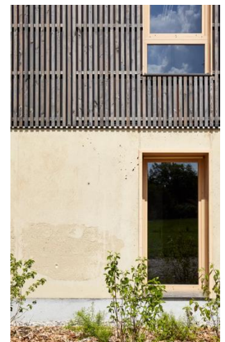
Pépinière d'entreprises "Le Cap" : Construction en béton d'argile coulé et bois ZAC de la Corderie - St-Clair-de-la-Tour Architecte : Reach&Scharff / ©Kévin Dolmaire
